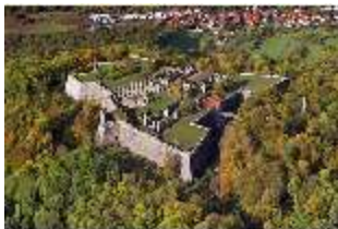
RoFg.I, Luftaufnahme, DI015777, BSV-
