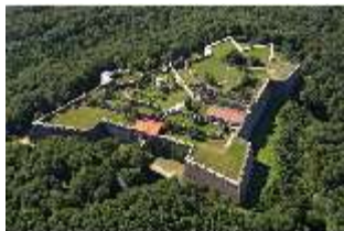
RoFg.I, Luftaufnahme, Blick von Nordosten, DI000217, BSV
